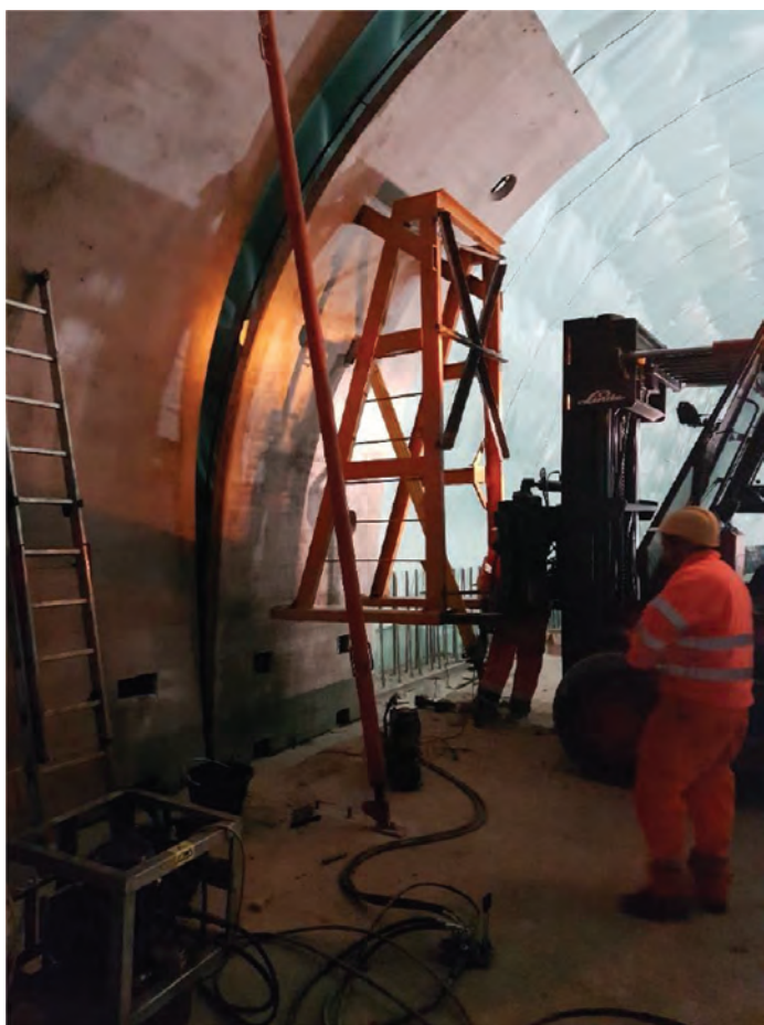
Figura 2. Galleria "Cesaronica", posa di predalles in c.a. prefabbricate.
